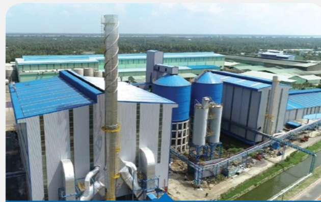
Hệ thống đồng phát hơi điện
