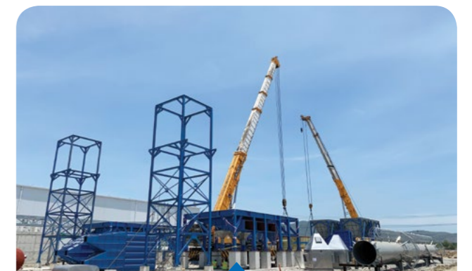
Thi công kết cấu thép
